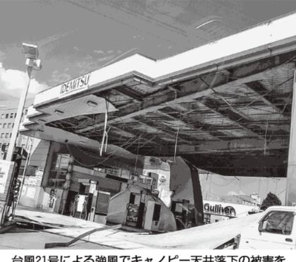
台風21号による強風でキャンピー天井落下の被害を受けたSS (写真提供: 京都石商)
